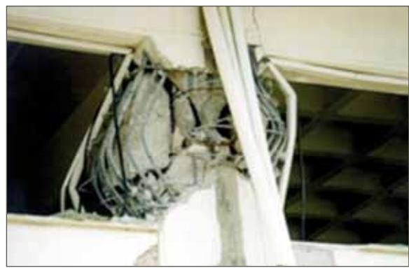
**Figura 10.** Esempio di danno localizzato in una struttura in cemento armato (grave danno alla testa di un pilastro a causa della presenza delle tamponature di altezza limitata per la realizzazione di finestre a nastro).
