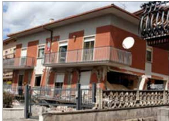
**Figura 9.** Esempi di crollo e danneggiamento in edifici in cemento armato (a destra: crollo di tamponature e danni locali a pilastri e nodi; a sinistra: crollo totale del piano terra)
