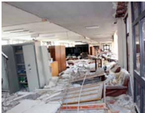
**Figura 11.** Due esempi di danno agli elementi non strutturali: crollo parziale ed espulsione della tamponatura esterna in un edificio in cemento armato (sinistra); crollo rovinoso di tramezzi divisorii all'interno (destra).
