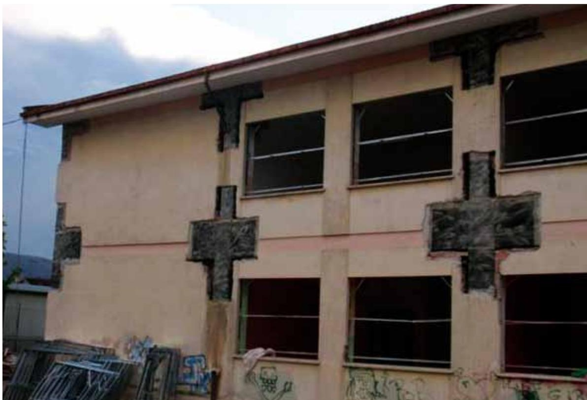
**Figura 1.** Esempio di rafforzamento di nodi strutturali
