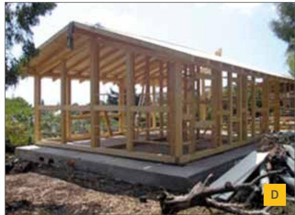
Figura 7. Esempi di struttura portante: a) muratura, b) cemento armato, c) acciaio, d) legno.
